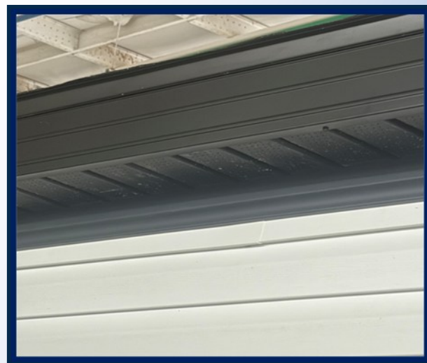
BLACK FASCIA, SOFFIT, DRIP EDGE & CROWN
